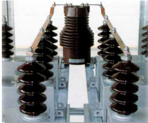
View of current transformer between two star centres of a bank of capacitors. Vue du transformateur de courant entre deux centres étoile d'une batterie de condensateurs.
